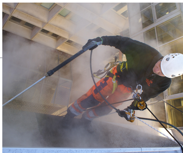
Här tvättar vi Rymdstyrelsens fasad i Solna. Fastighetsägare är Vasakronan.
